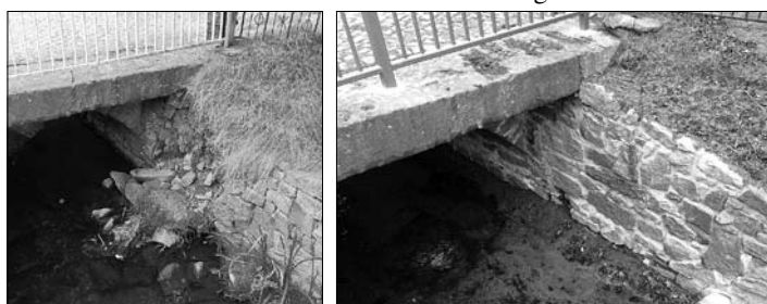
Brücke Berggäßchen vorher und nachher
