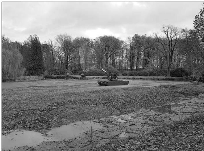
Mehrere Bagger, Kettendumper und ein Spezialgerät zur Teichentschlammung sind hier seit Oktober im Einsatz. Gleichzeitig werden mehrere Abschnitte der Ufermauer sowie die Bootsanlegestelle neu gebaut. Der durch die beiden Sturmereignisse stark in Mitleidenschaft gezogene Baumbestand wurde durch Fachfirmen gepflegt und umsturzgefährdete Exemplare entfernt. Diese Arbeiten sind jetzt zum überwiegenden Teil beendet.
