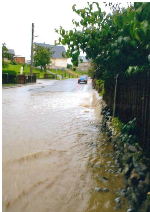
Abbildung 1-9: Straßendurchlass des Mühlgrabens an der Obergersdorfer Straße in Gersdorf (2013)
